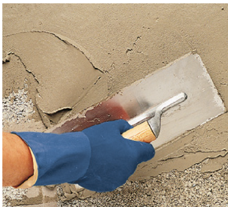
Aplicación de Planiseal 68 con llana
