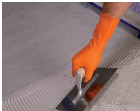
Aplicación de la primera capa de Monolastic armada con Mapetex Sel N sobre un recocado nuevo
