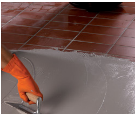
Aplicación de la segunda capa de Monolastic sobre Mape-net 150
